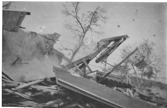
14. 取除きの建物は最後の手段としてロープで引倒されて除去
