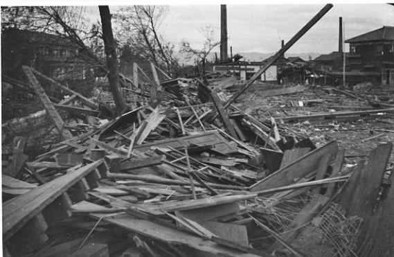
7. 倒壊して見る影もない北側校舎
