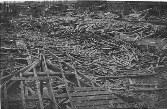
5. 倒壊した校舎の木材や瓦で足を入れる餘地もない
