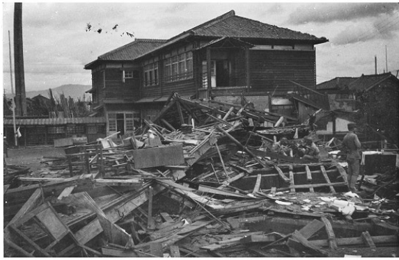
2. 残った校舎と倒壊した校舎
