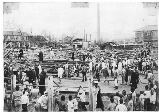
28. 昭9.9.23倒れた校舎跡かたづけ 手前は校地西北隅にあった鉄棒と砂場。右上の校舎は残った玄関の校舎。左上は蒲生町の民家。斜後の立樹は、川べりの木々で枝葉は飛散していた。校下各種団体総出勤の跡かたづけ。便所だけは白壁のまま立っていた。長い煙突は校地東空地にあった。
