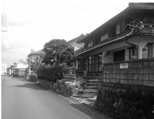
【写真3】 宅地をかさ上げた民家が並ぶ旧街道 (福知山市和久市町)
