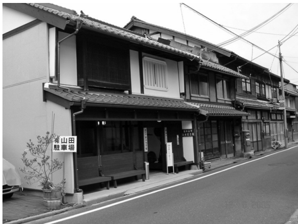
【写真5】福知山市治水記念館 （明治初期の町家を改装した。福知山市下柳町）
