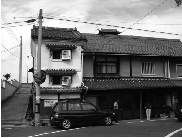
【写真1】明治26年建築の町家（元呉服卸商、土蔵一階部は土盛りでかさ上げされている。左端は由良川堤防と大正時代までであった由良川水運の船着き場に続く階段。福知山市菱屋町）
