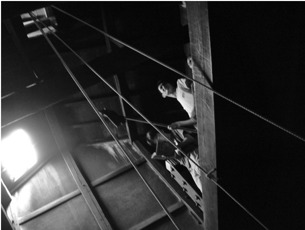
【写真2】写真1の町家の荷揚げ用滑車のロープとタカ（人物がいるテラス状の板の間）
