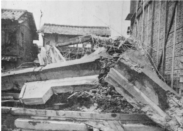
第8図 淳和小学校コンクリート壁の倒壊（京都市 1) ）
