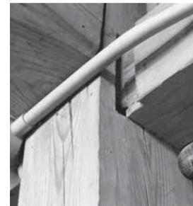
写真 10 柱 X3Y7 の折損と横架材の抜け
