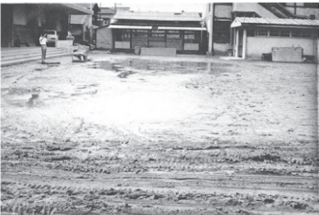
写真5 S小学校体育館周辺 (水害後：1972年7月14日)
