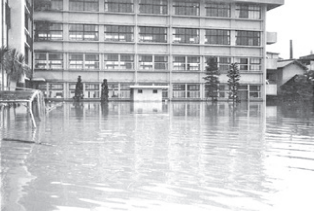
写真1 S小学校校舎周辺 (水害時：1972年7月12日)
