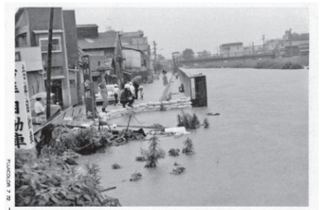
写真6 住道大橋付近の水防作業（月の輪工） (水害時：1972年7月12日)
