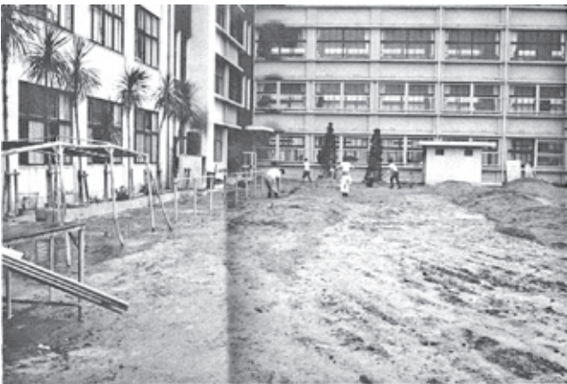
写真3 S小学校校舎周辺 (水害後：1972年7月14日)
