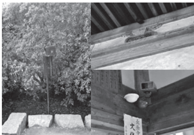
写真11 C寺の本堂内外に設置されたセンサーとカメラ
