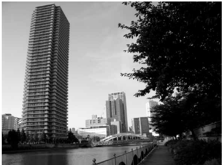
写真1：大阪市の土佐堀河岸のタワー型高層集合住宅
