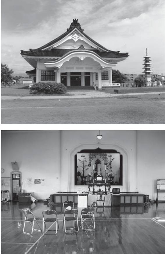
図15 函館大火慰霊堂（上：正面 下：内部）
