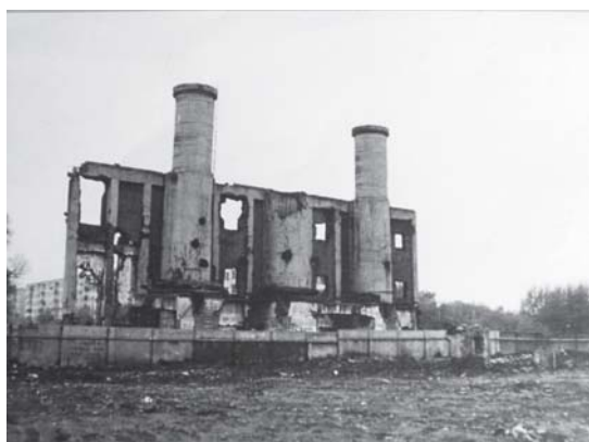
写真3 整備が進む731部隊遺跡 動力班旧跡
