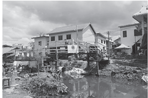
カムパン・ヌガム地区に新たに建設された橋。
