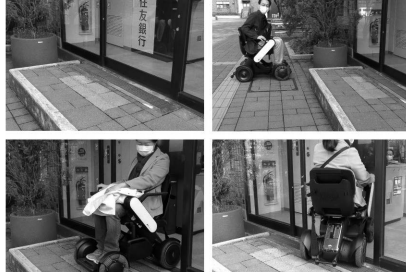
写真1-4：ATMまでのスロープの幅が狭いため、入退出の際に、左右に方向転換するのが難しく、スロープから落ちそうなおもとと取られました。
