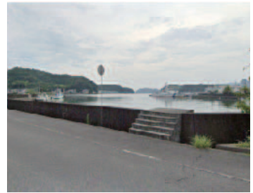
図-2 既存の防潮堤
