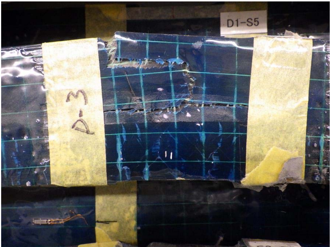
写真-付 4.24 曲げ荷重試験後における CFRP の破壊状況 (試験体 D-b 幅方向 裏)
