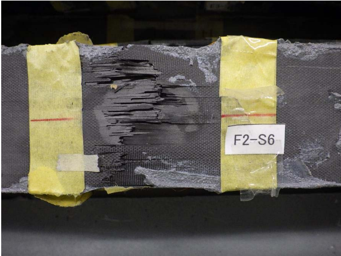
写真-付 4.17 圧縮載荷試験後における CFRP の破壊状況 (試験体 F-c 幅方向 引張側)
