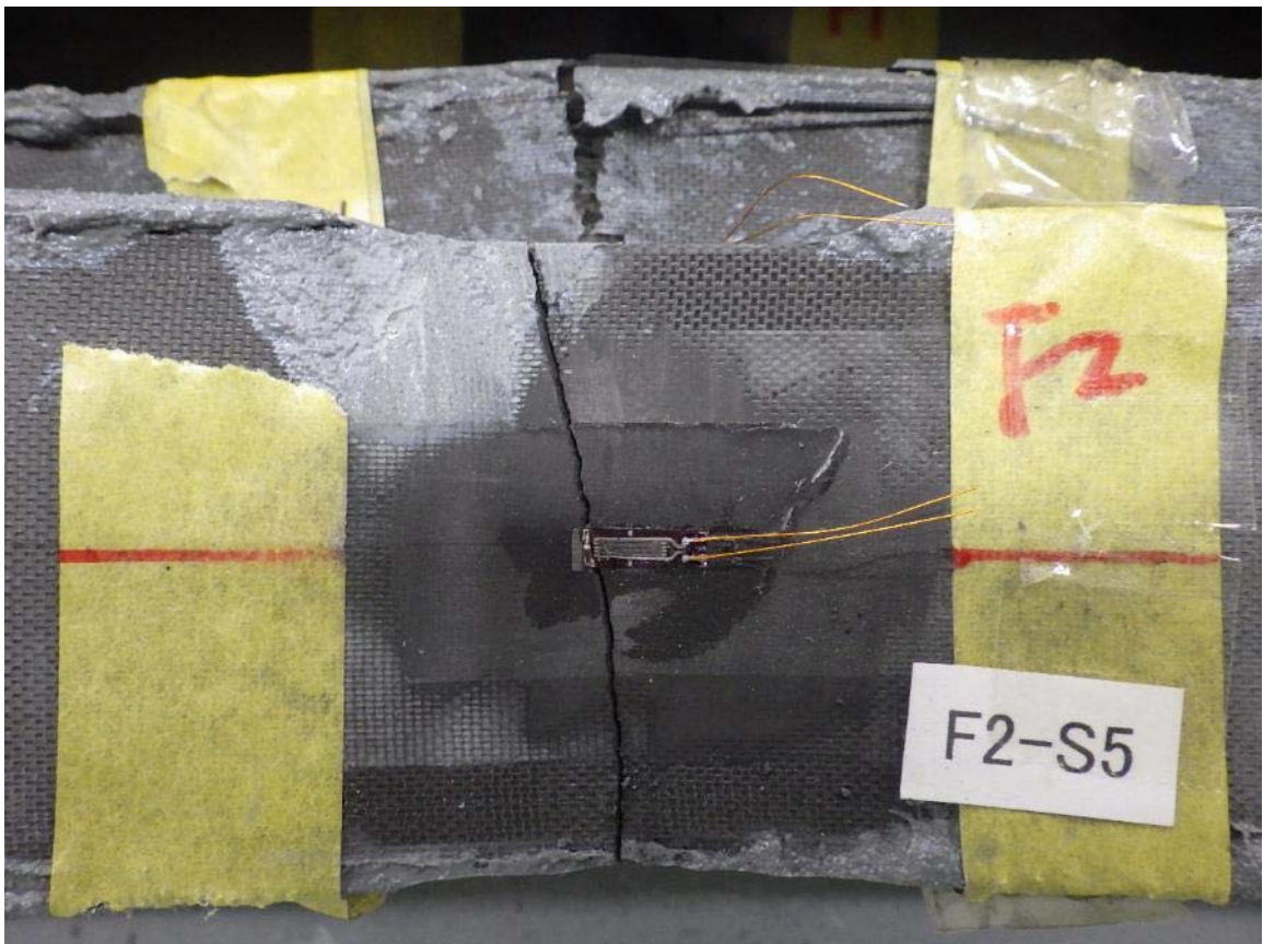
写真-付 4.16 圧縮載荷試験後における CFRP の破壊状況 (試験体 F-c 幅方向 圧縮側)
