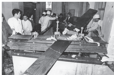
破壊された教室のかたづけを手伝う生協食堂の職員
