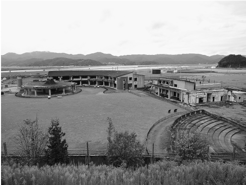
写真7：裏山（南側）からみた大川小学校校舎
