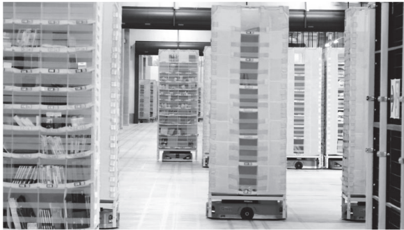
図2 Amazon Robotics が用いられている物流倉庫
