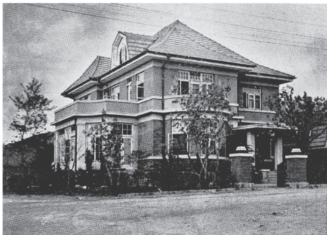
図1 大連の日本人住宅（遠藤邸） 『満洲建築雑誌』第14巻第5号，1934年より引用
