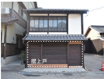
図9. 摺上戸の設置事例
