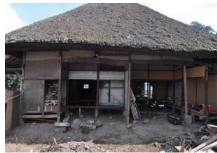
写真1 茅葺屋根の古民家
