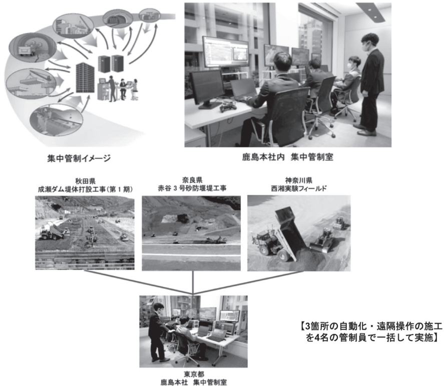
図 22 鹿島建設の遠隔集中管制システムの実証実験
