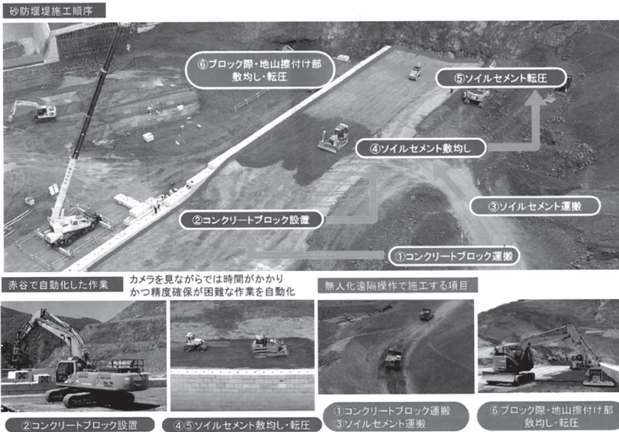
出所) 鹿島建設赤谷工事事務所提供の資料より借用。
