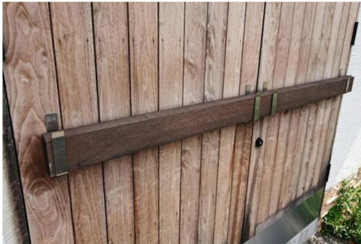
図 3.22 一般的なかんぬき。門扉を固定する機構として広く用いられる。かんぬきを外すためには、一旦重力に逆らって鉛直上にかんぬきを持ち上げてから、かんぬきを下に下さなければならない。
