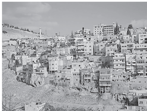
写真2 東エルサレムの家屋破壊（シルワン地区） 出典：筆者撮影（2013）
