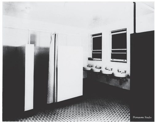
写真3 児童用洗面所 浴室 便所
