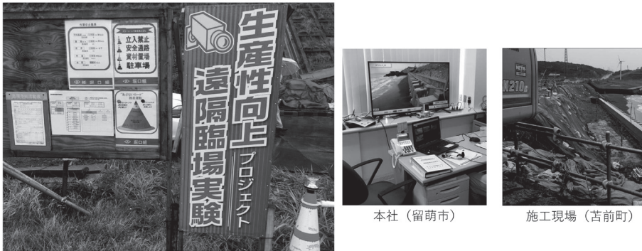
工事現場（苫前町）
