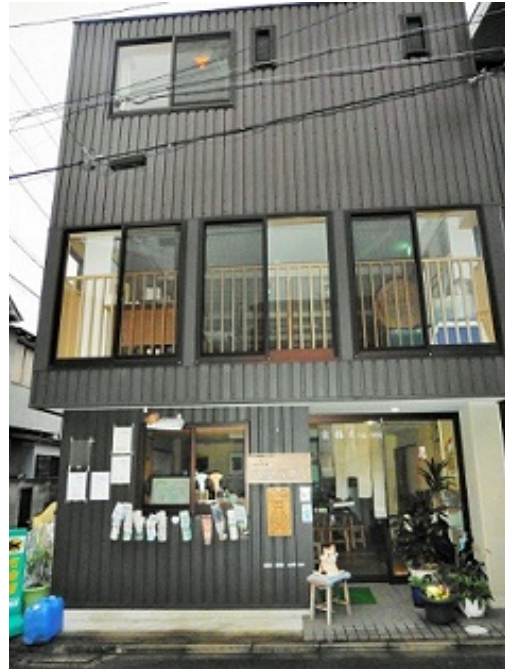
写真 12 建て替え後のハルハウス まちの学び舎ハルハウス提供
