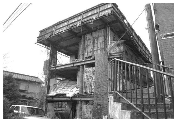
図1 外壁が崩落した前面写真（右側が A 棟） 図2 外壁だけでなく軒下も崩落
