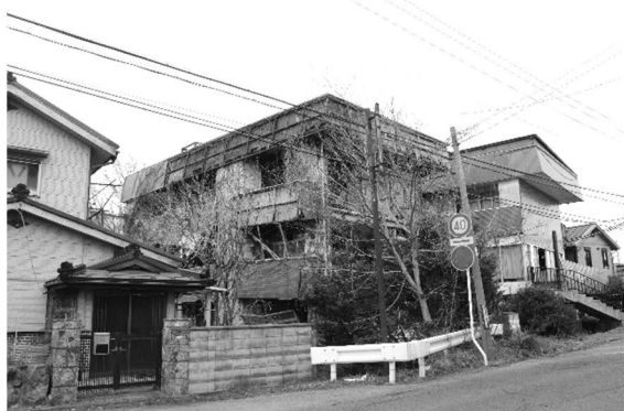
図1 外壁が崩落した前面写真（右側が A 棟） 図2 外壁だけでなく軒下も崩落
