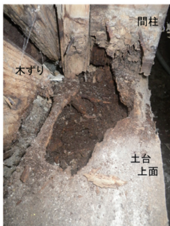
写真7 1階床下部材の生物劣化の事例2（蟻害）
