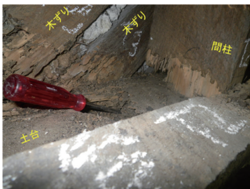
写真6 1階床下部材の生物劣化の事例1（蟻害）
