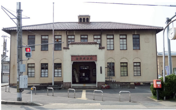
写真 1 旧加悦町役場庁舎 正面 (改修前)
