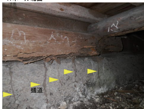
写真6 1階床下部材の生物劣化の事例1（蟻害）
