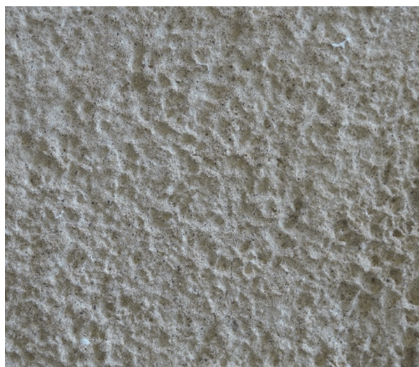
外壁のスタッコ仕上げ
