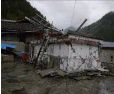
Fig. 10 Wall inclination
