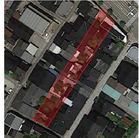
図3 金屋町重伝建地区の連担する中庭 (Google マップより引用し筆者加筆)
