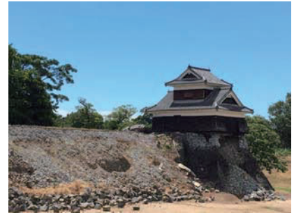
図 1.4 熊本地震による熊本城石垣の 崩壊被害
