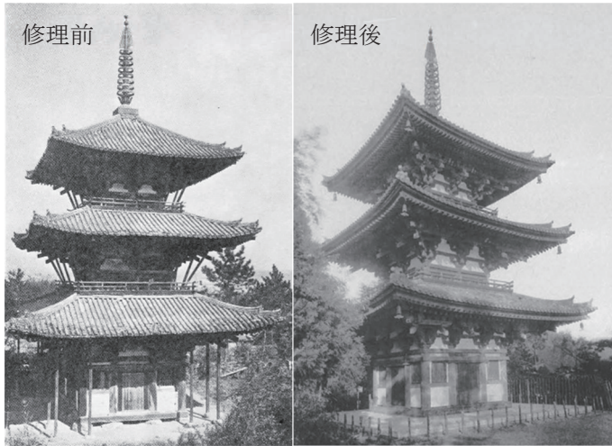
a: 修理前 b: 修理後
