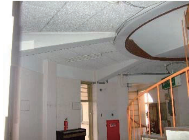
写真4 中央螺旋階段付近 見上げ
