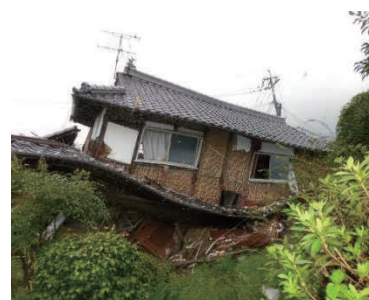
図5 A氏伝統的木造家屋の被害写真
