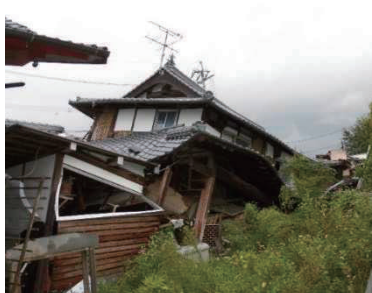
図4 A氏伝統的木造家屋の被害写真
