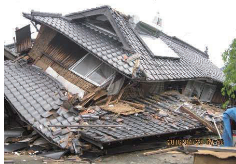
図2 伝統的木造家屋の被害
