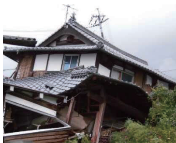
図6 A氏伝統的木造家屋の被害写真
