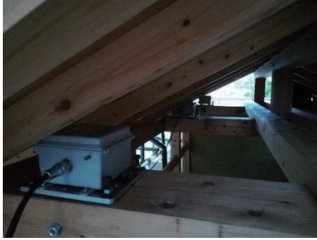
写真2 加速度計設置状況
