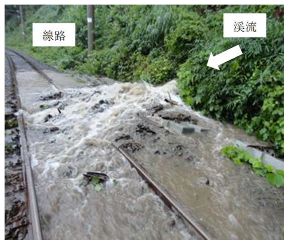
図-1.5 線路への土砂流入・土石流の例（その 2）
