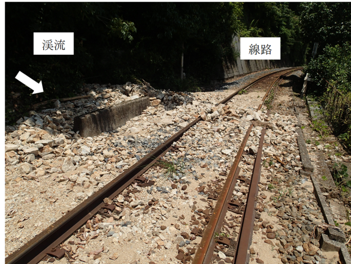
図-1.6 小規模な土砂流入・土石流の例（その 1）
