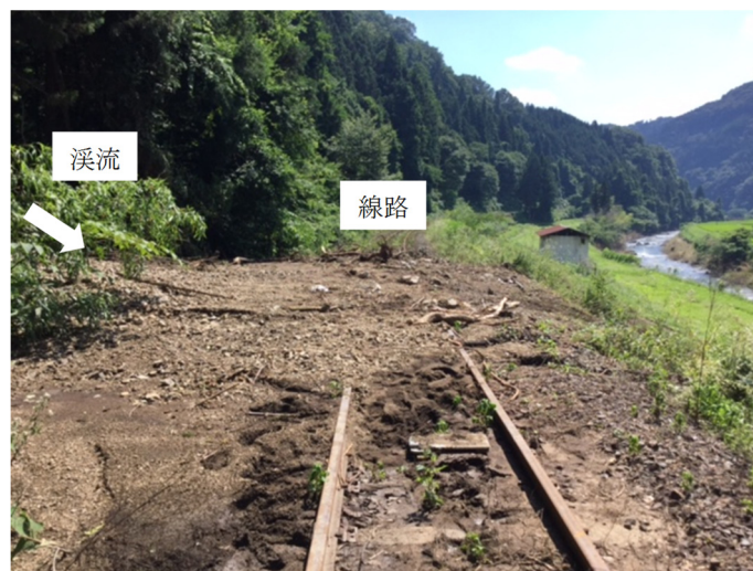
図-1.7 小規模な土砂流入・土石流の例（その 2）
