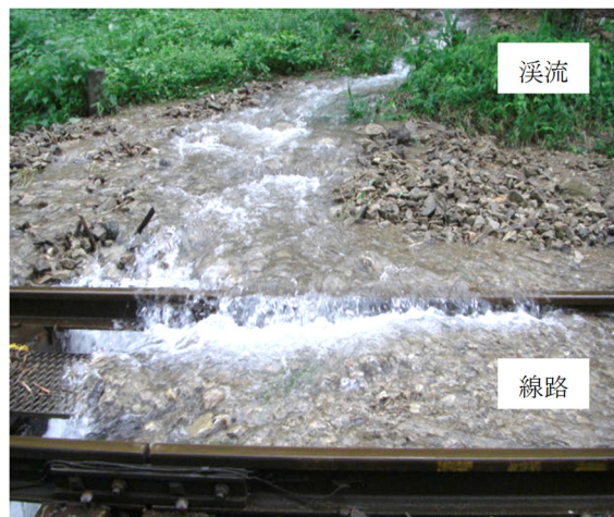
図-1.4 線路への土砂流入・土石流の例（その 1）
