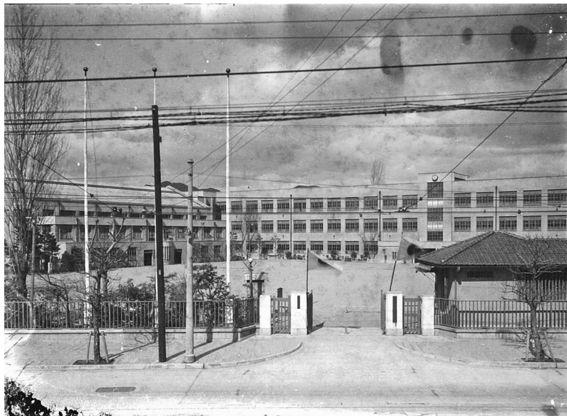
【写真二七】新校舎完成後の北大路学舎全景（昭和13年）
