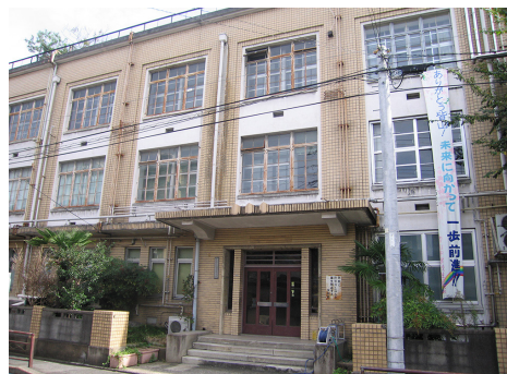
写真5 皆山中学校 1936年竣工・RC造・京都市営繕課設計(2007年10月13日撮影)
