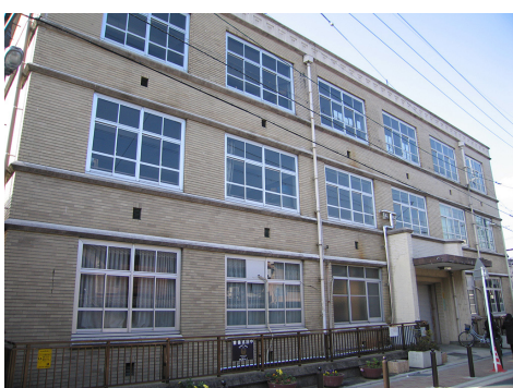
写真4 六原小学校 1930年竣工・RC造・京都市営繕課設計(2007年2月3日撮影)
