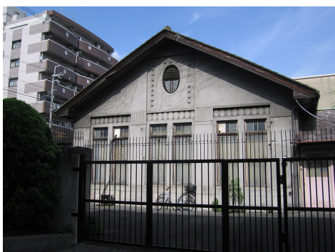
写真2 内職補導センター 1936年竣工・RC造(2006年7月22日撮影)
