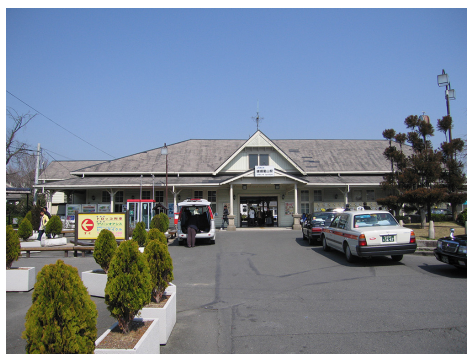
写真12 JR嵯峨嵐山駅駅舎 1897年竣工・木造(2006年3月5日撮影)
