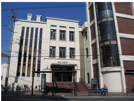
写真1 上京区役所 1937年竣工・RC造(2007年2月13日撮影) 以下、写真撮影はすべて筆者による
