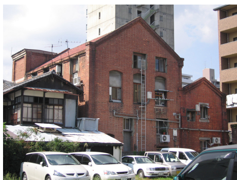
写真13 梅香荘 1895年竣工・石造+煉瓦造(2006年9月21日撮影)
