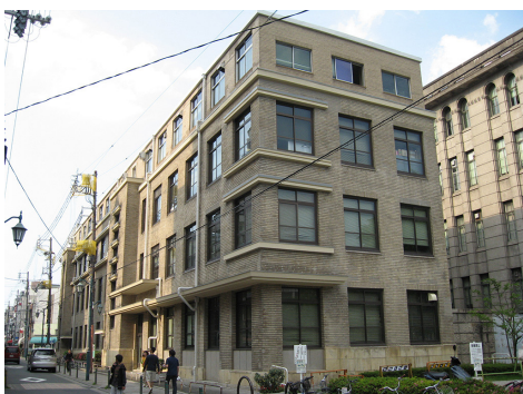
写真3 中京保健所 1931年竣工・RC造(2008年5月17日撮影)
