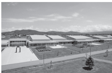
写真 3 新設東川町小学校
