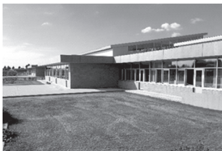
写真 2 新設東川町小学校
