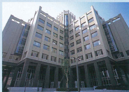
びわこ・くさつキャンパスのシンボル棟アクロスウイング
