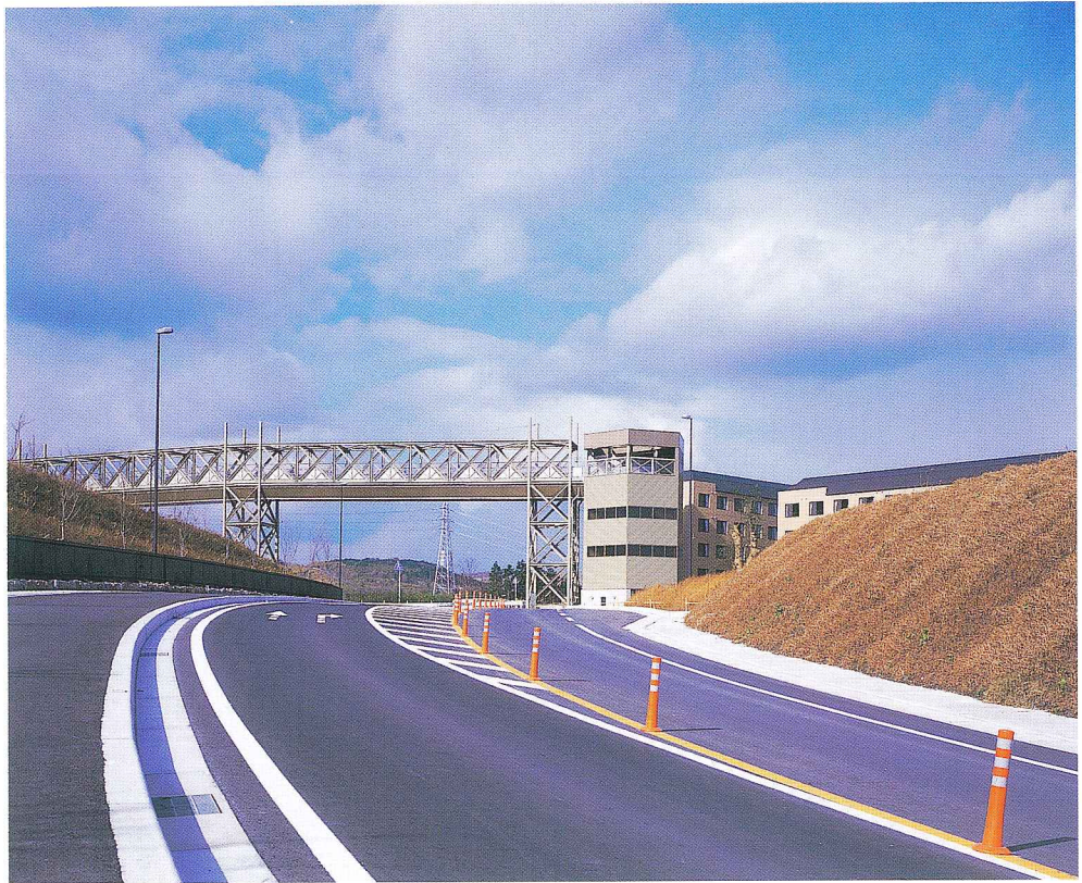
連絡歩道橋 EV棟
