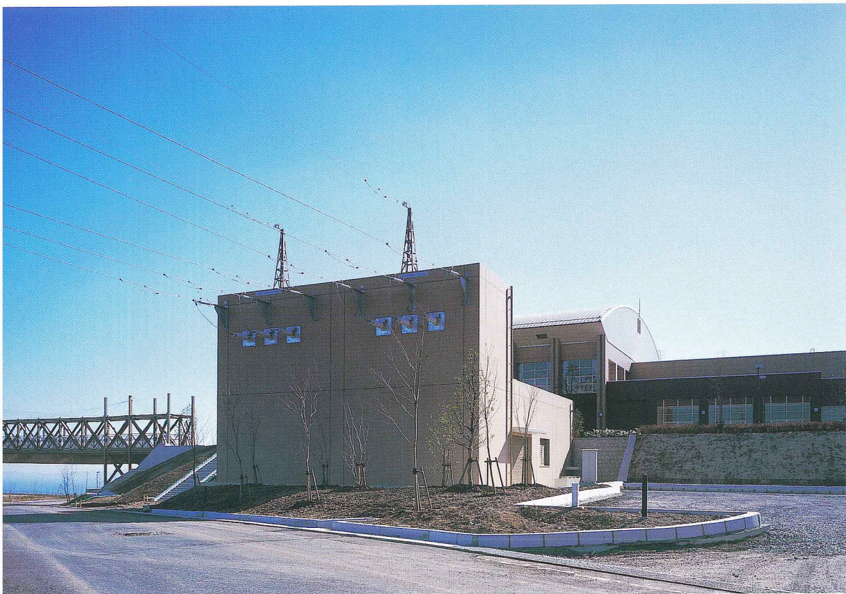
エネルギー施設棟
