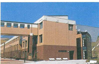
Building D — Media Center D棟 (メディアセンター)
