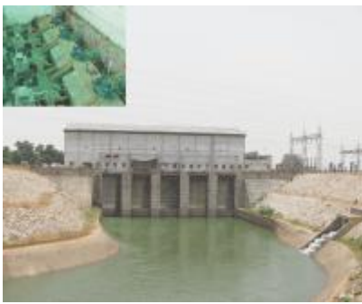
(d) 20 MW Samal Small Hydro Power Project in Odisha
