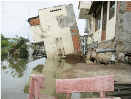
図 1.11: 河岸崩壊による家屋の倒壊
