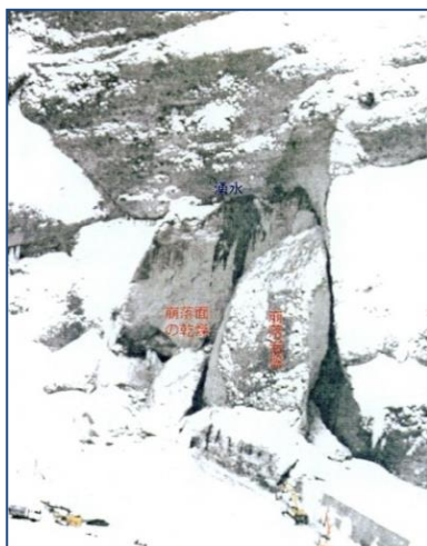
写真 1.1.1 豊浜トンネル 2)
