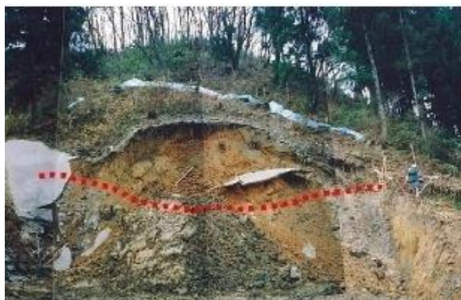
写真 1.1.8 坑口付け掘削時の崩壊事例 10)
