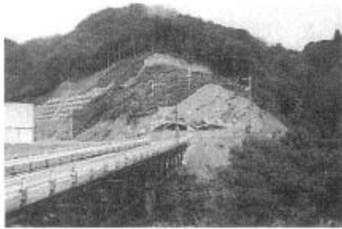
写真 2.2.1 子持トンネル坑口部の崩壊状況 7)
