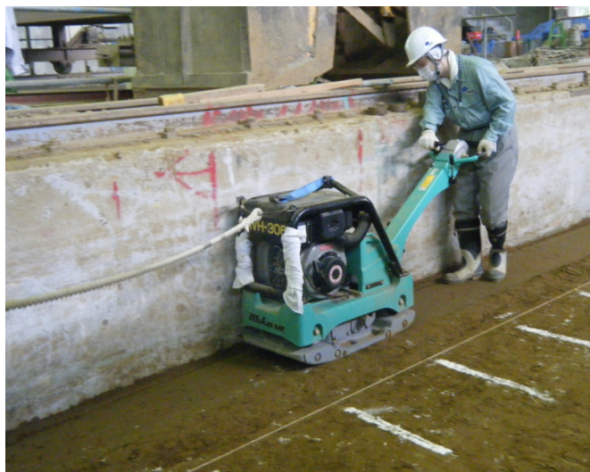
写真-3.4 走行状況
