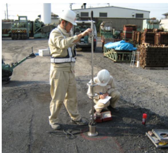
写真-5.7 小型 FWD 計測状況
