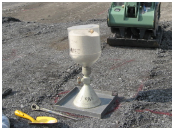
写真-5.6 砂置換法計測状況
