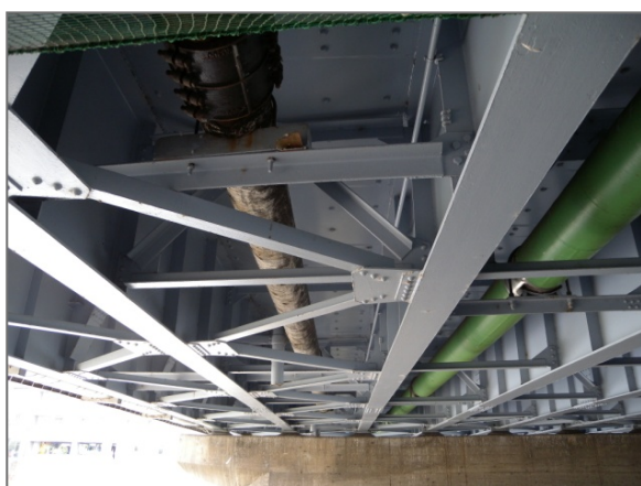
写真4 五条大橋下の送水管
