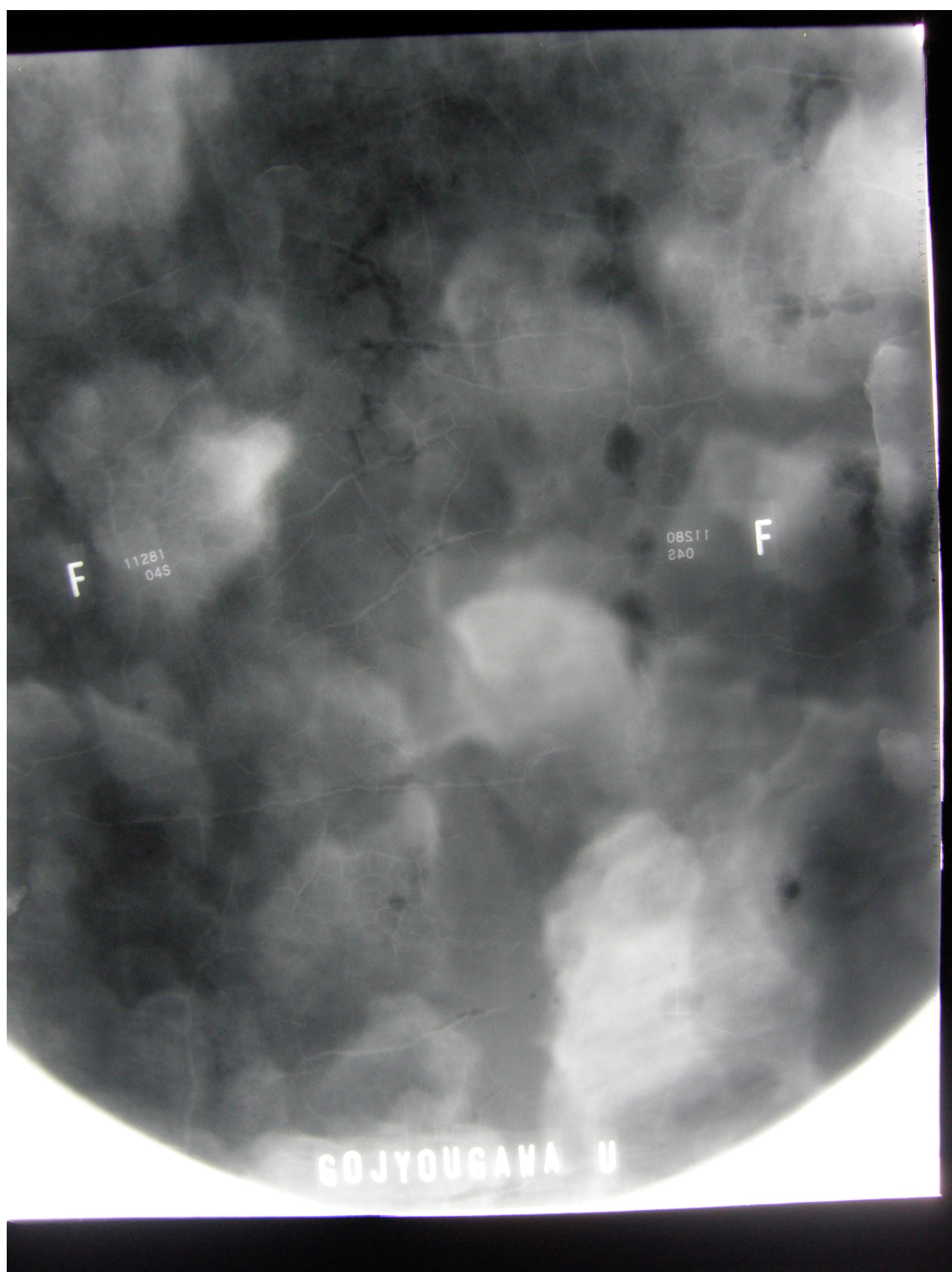
X線フィルム3 五条大橋下の送水管（上から撮影：鉄管）
