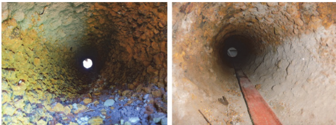
写真 2—9 人力錆落とし作業の前・後（渉成園北で掘削された配管）
