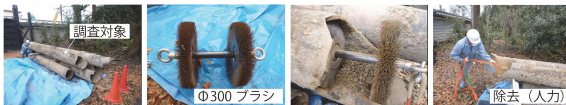
写真 2-4 管内錆こぶ落とし検査を実施した涉成園北の発掘管路
