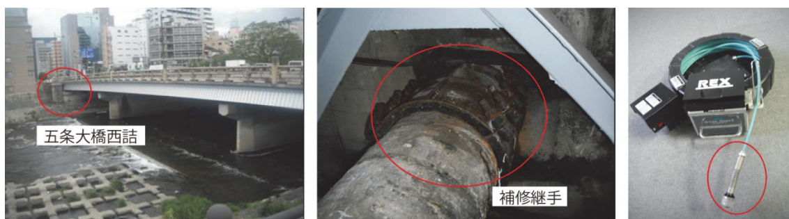
写真 2-3 管内カメラ検査を実施した五条大橋の管路（割型補修継手）とカメラ（右）
