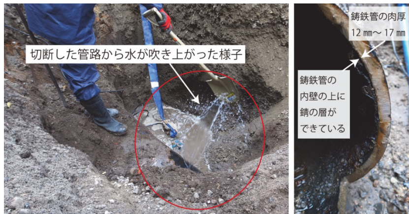
写真 2-6 涉成園北管路の掘削状況（左）、管内状況（右）
