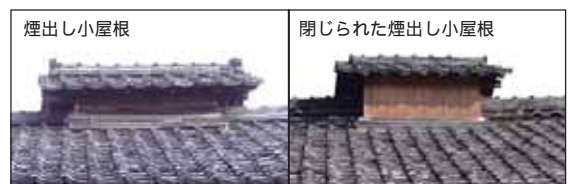
図9 防火対策のある煙出し小屋根
