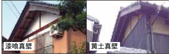
図16 漆喰真壁・黄土真壁
