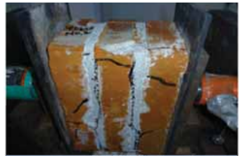
写真2 煉瓦や目地に亀裂（圧縮応力 1.45N/mm 2 ）
