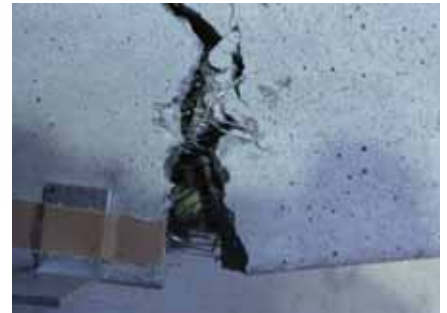
写真5 コンクリート降伏後の状況
