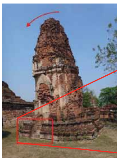
写真5 構造物の傾きにより基礎部分がせん断破壊した状況
