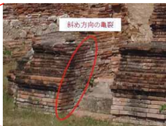
写真5 構造物の傾きにより基礎部分がせん断破壊した状況
