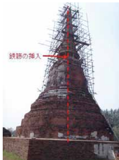
写真2 修復工事の状況
