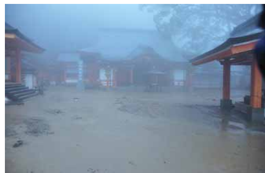
図3 熊野那智大社拝殿前の状況
