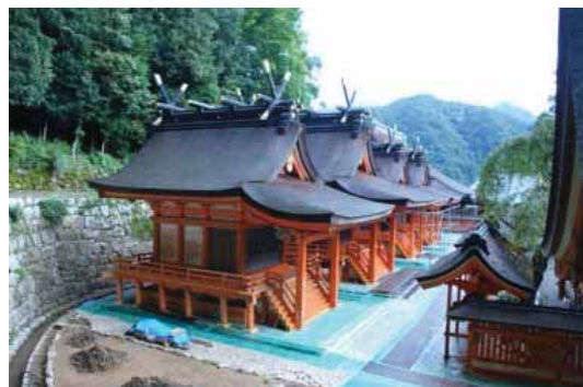
図5 御本殿裏の災害復旧後の状況
